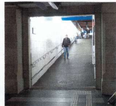
Hbf. BIEL/BIENNE (↑ 9.2020) (Standard-) RAMPE: (vgl.←) 10,7 % Steigung/Neigung 3,85 m Höhenunterschieds- Überwindung 36 m Länge 2,5 m Breite (vgl.↓)
